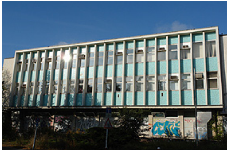
Neues Produktions- und Verwaltungsgebäude, 1958 fertiggestellt. (Zustand von 2003) – © Pete Shacky
