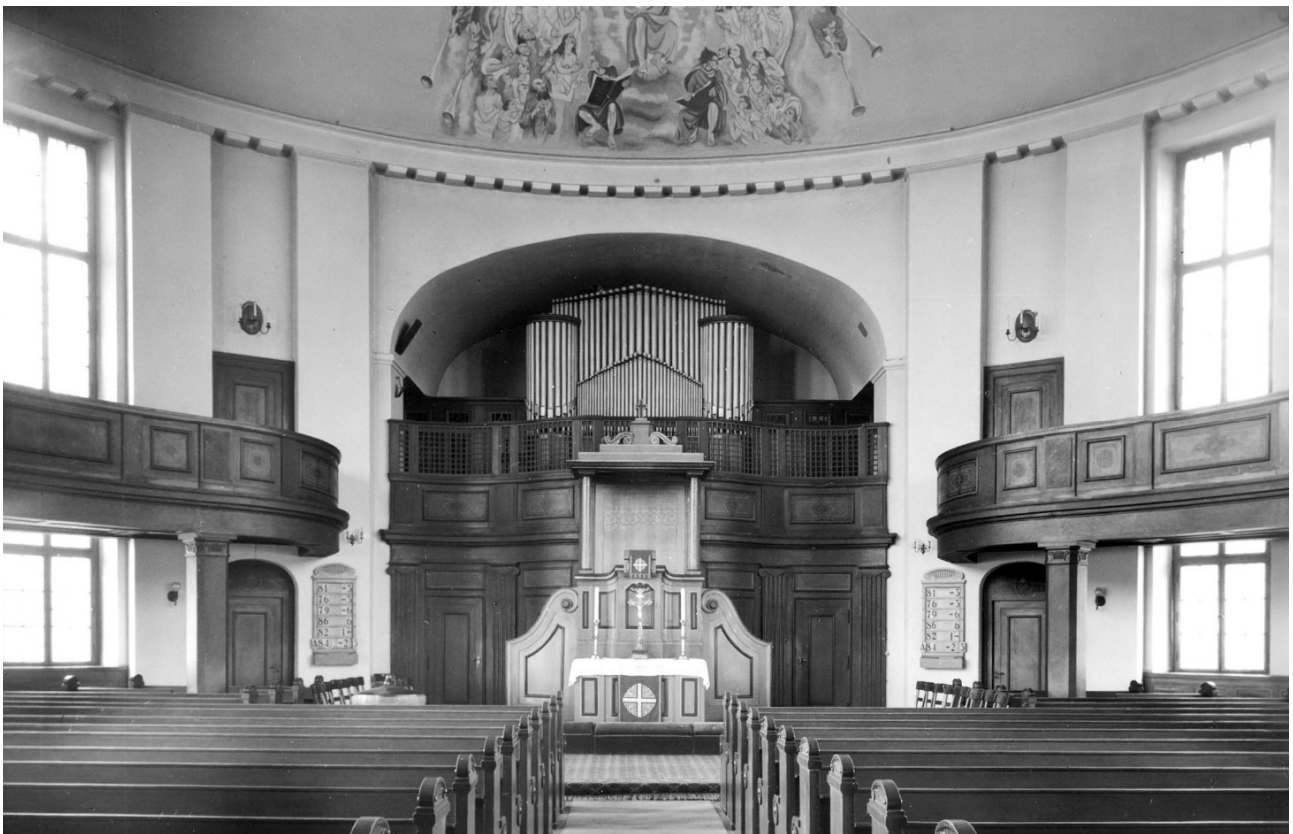
Die Dinse-Orgel der Johanneskirche von 1914 mit einem zeittypischen Aussehen: es ist kein Orgelgehäuse zu erkennen, sondern: die Front besteht aus Reihen vermutlich stummer Orgelpfeifen, das eigentliche Orgelwerk ist dahinter angeordnet. (Foto: Ev. Johannes-Kirchengemeinde in Lichterfelde-West)
